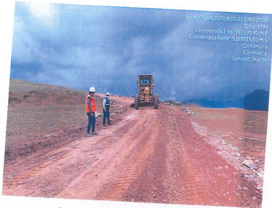
Ilustración 11. Conformación de la capa de afirmado.
