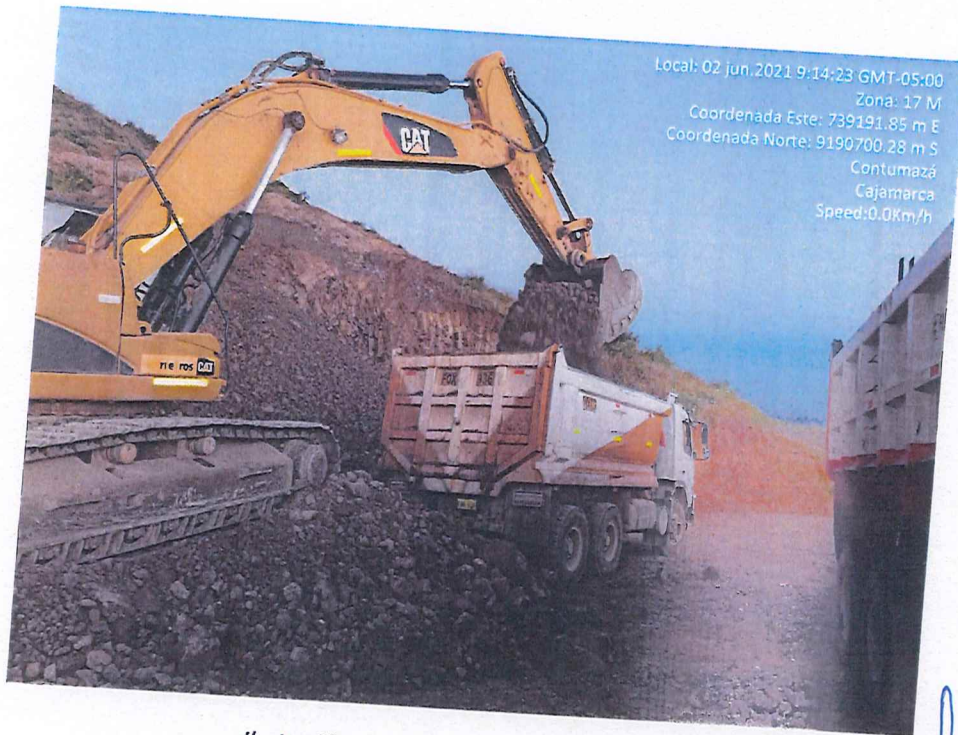
Ilustración 6. Carguío y acarreo de material.
