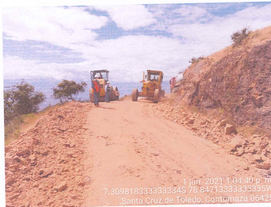
SE OBSERVA AL INSPECTOR Y RESIDENTE DEL SERVICIO, REALIZANDO LA VERIFICACION DE EL NIVELADO CON MOTONIVELADORA DE LA CAPA DE AFIRMADO.
