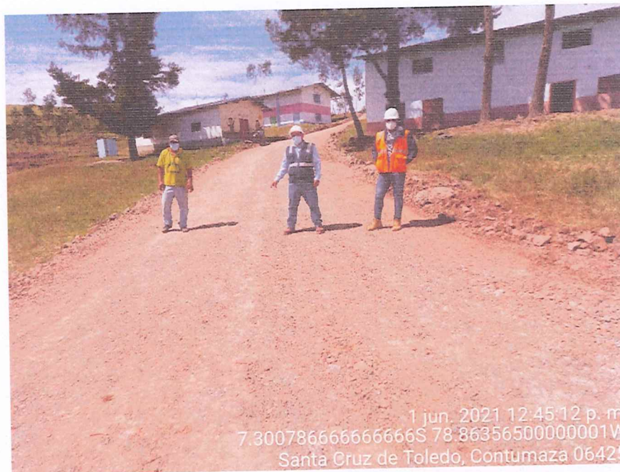
SE OBSERVA LA VERIFICACIÓN POR PARTE DEL INSPECTOR DEL SERVICIO, RESIDENTE Y AUTORIDAD DEL PUNTO FINAL DEL TRAMO EN MANTENIMIENTO.
