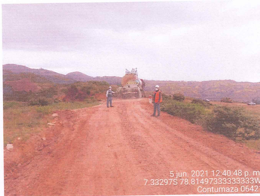
SE OBSERVA AL INSPECTOR DEL SERVICIO, CONJUNTAMENTE CON RESIDENTE VERIFICACANDO EL REGADO DE LA CAPA DE AFIRMADO CON CAMION CISTERNA.
