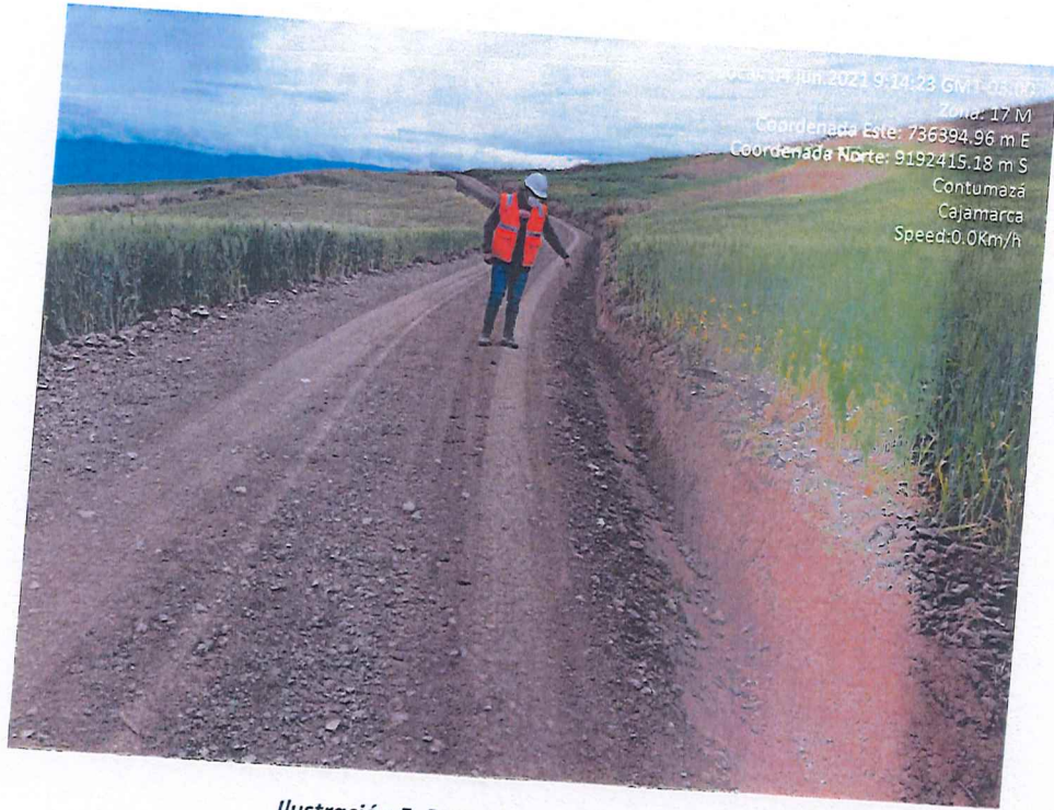
Ilustración 5. Reconformación de cunetas.
