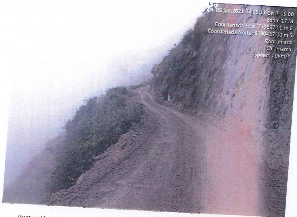
Ilustración 16. Resultado del trabajo de compactación del afirmado en el Mal Paso.
