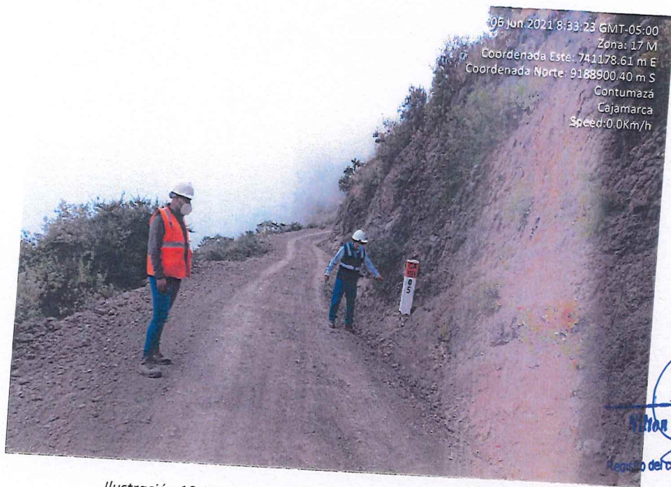
Ilustración 18. Verificación de Colocación de postes kilométricos.
