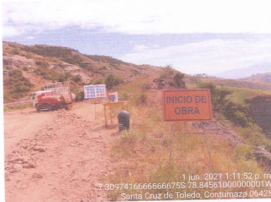
SE OBSERVA EL LUGAR DONDE SE CONTINUA CON EL REINICIO DE LAS ACTIVIDADES DEL MANTENIMIENTO PERIODICO.
