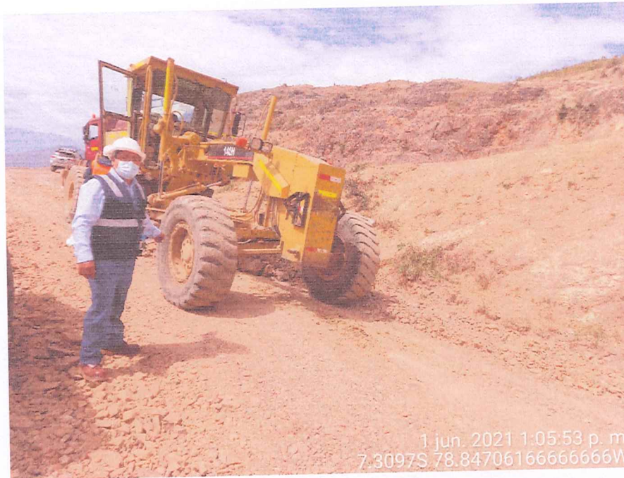
SE OBSERVA AL INSPECTOR DEL SERVICIO, REALIZANDO LA VERIFICACION DE EL NIVELADO CON MOTONIVELADORA DE LA CAPA DE AFIRMADO.
