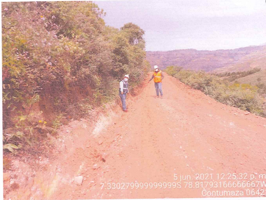
SE OBSERVA AL INSPECTOR DEL SERVICIO, CONJUNTAMENTE CON RESIDENTE VERIFICACANDO LA CONFORMACION DE LAS CUNETAS DEL MANTENIMIENTO.
