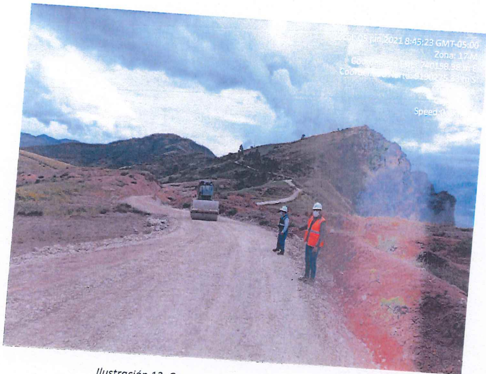
Ilustración 13. Compactación del material de afirmado.
