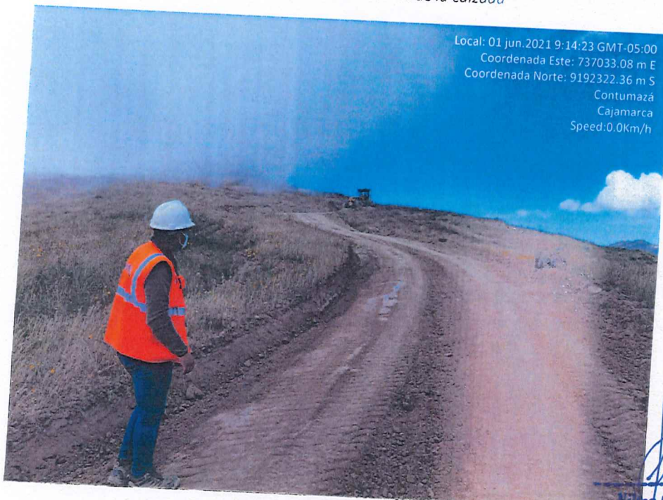
Ilustración 2. Trabajos de mejoramiento de subrasante.
