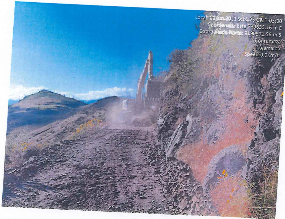
Ilustración 1. Ensanchamiento de la calzada
