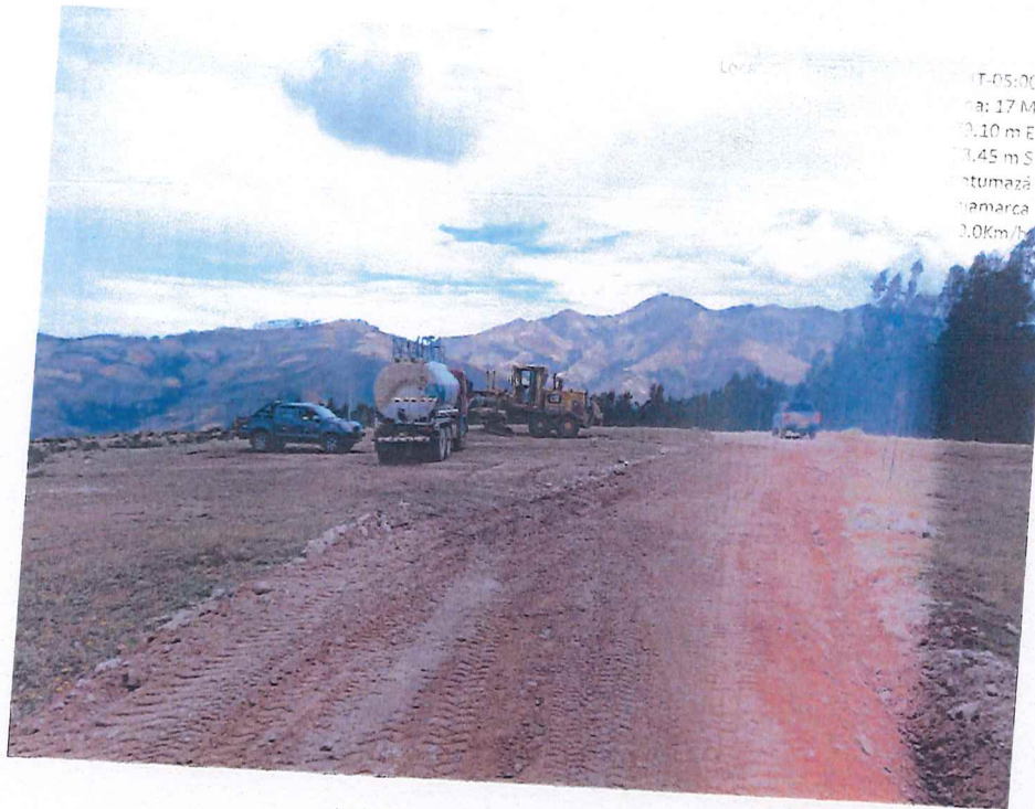
Ilustración 9. Parqueo de equipos.
