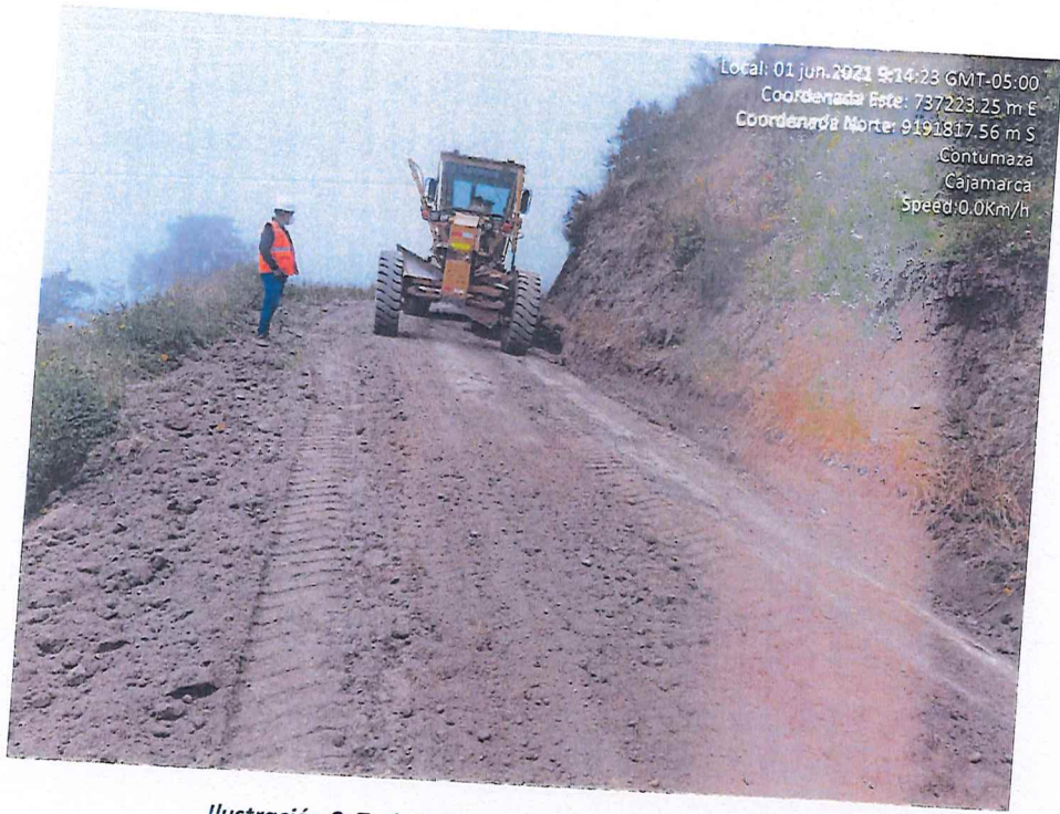
Ilustración 3. Trabajos de mejoramiento de subrasante.
