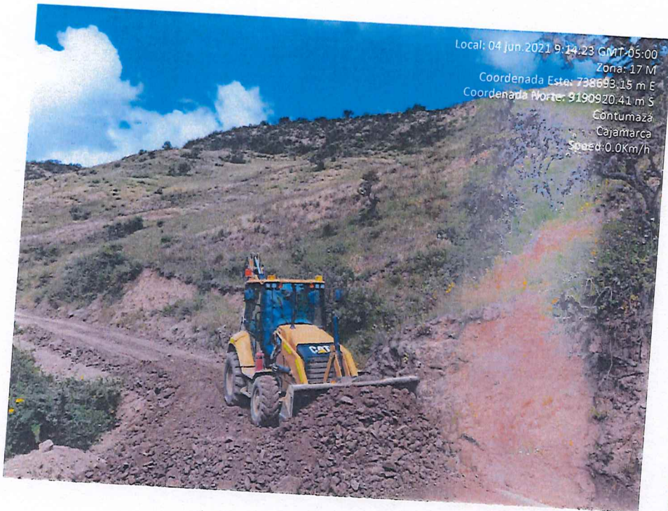
Ilustración 8. Extendido del material.
